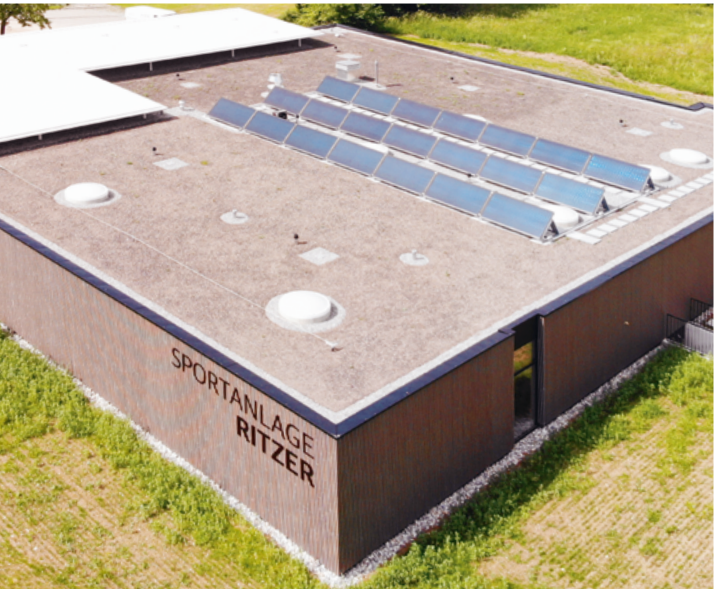
Installation solaire thermique
