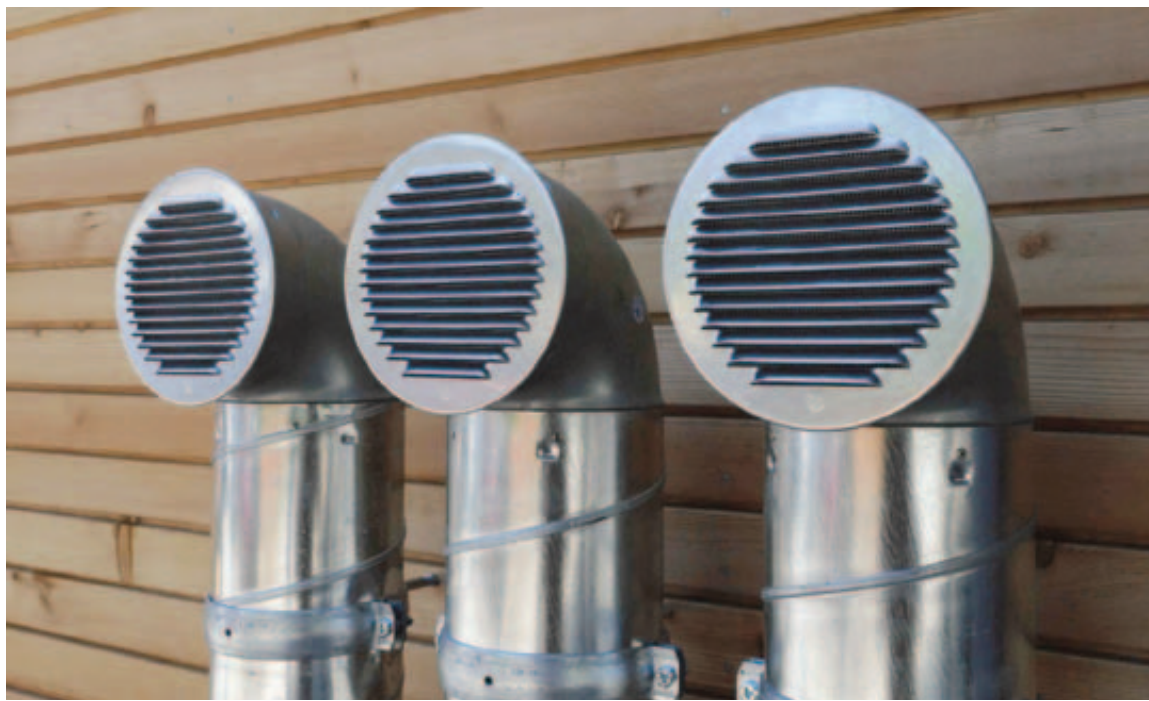
L'air «usé» est extrait par un système d'évacuation d'air. BÉATRICE DEVÈNES
